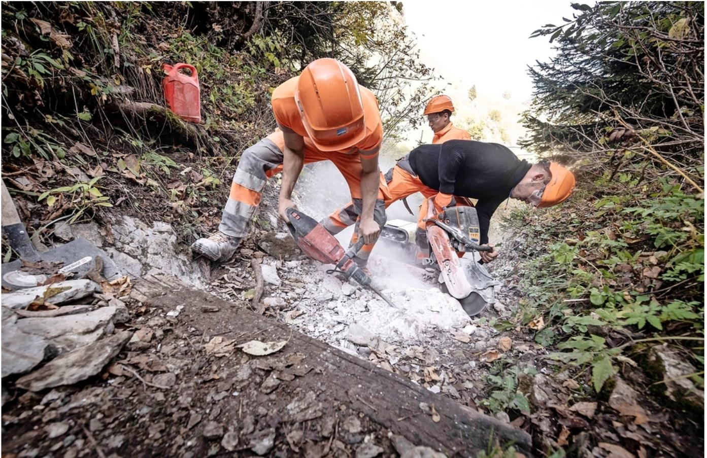
Les travaux consistent à créer de petits paliers, vers l'intérieur du gabarit du sentier d'environ 2 mètres de large.
